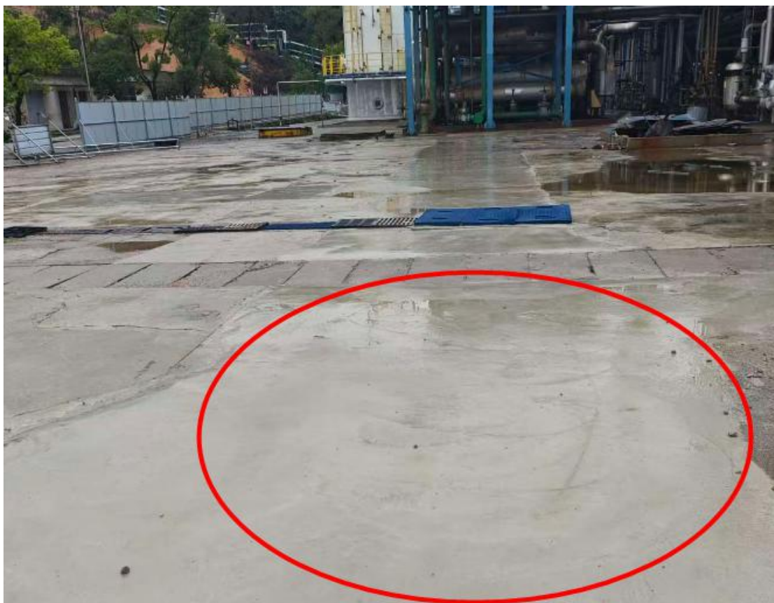
图 7.1-2 W9 监测井现场状况（水泥覆盖）
